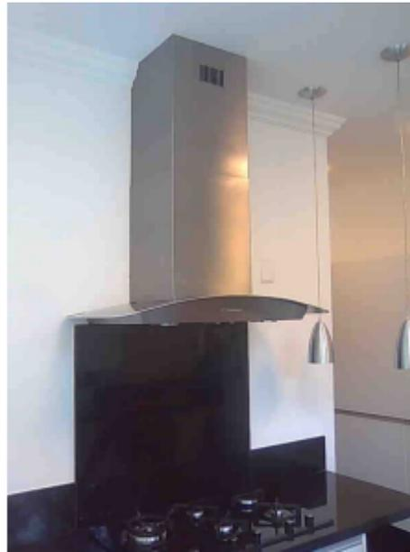
Coifa residencial para fogão 5 queimadores doméstico, com dois dutos deslizantes, motor, conjunto trafo e módulo filtrante no duto inferior, e retorno de ar limpo ionizado pelo duto superior. Possui medidas padrão de 500 mm (inferior) e 450 mm (superior), adequadas para pé direito de até 2650 mm. Largura de 900 mm entre os armários, consumo de energia de 81 Watts, baixo nível de ruído de 69 Db e vazão de 700 m<sup>3</sup>/h. Disponível nas medidas 90x65cm ou 80x65cm, em aço inox.
